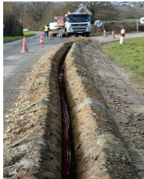
Exemple de tranchée nécessaire à l'enfouissement des raccords électriques
